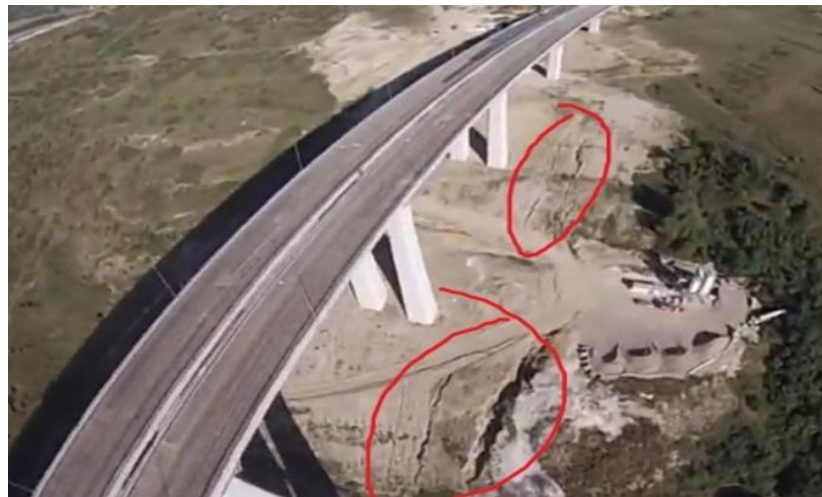
Fig. 2.5. Alunecare de teren pe șantierul autostrăzii Orăștie - Sibiu
