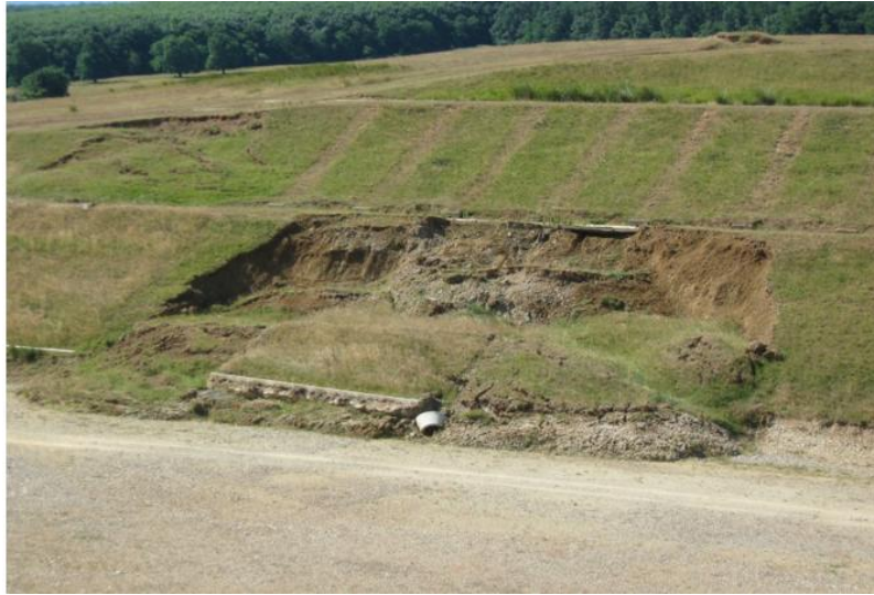
Fig. 2.4. Alunecare de teren pe șantierul autostrăzii în județul Bihor
